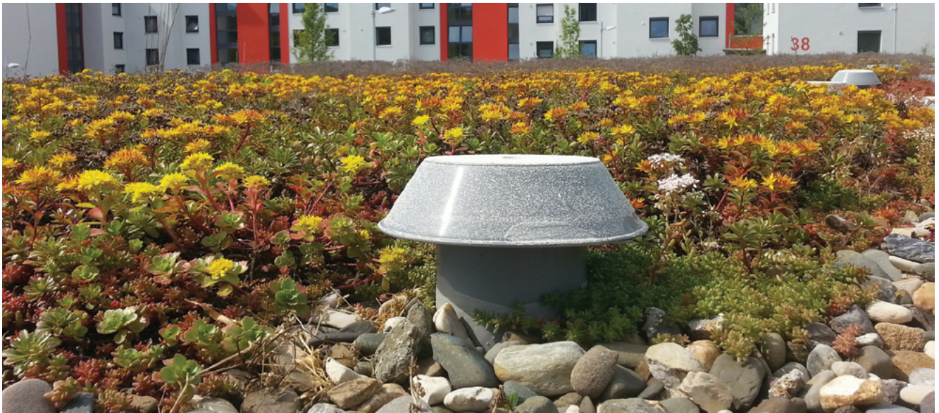
Neuer Lebensraum für Insekten entsteht z.B. durch Dachbegrünung
