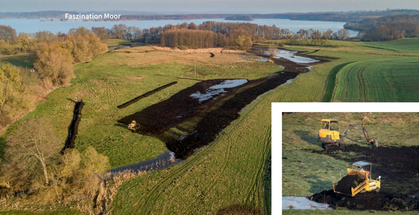
Am Südufer der Lieps trugen die Bagger Torfboden flach ab, um damit die Entwässerungsgräben zu verschließen.
